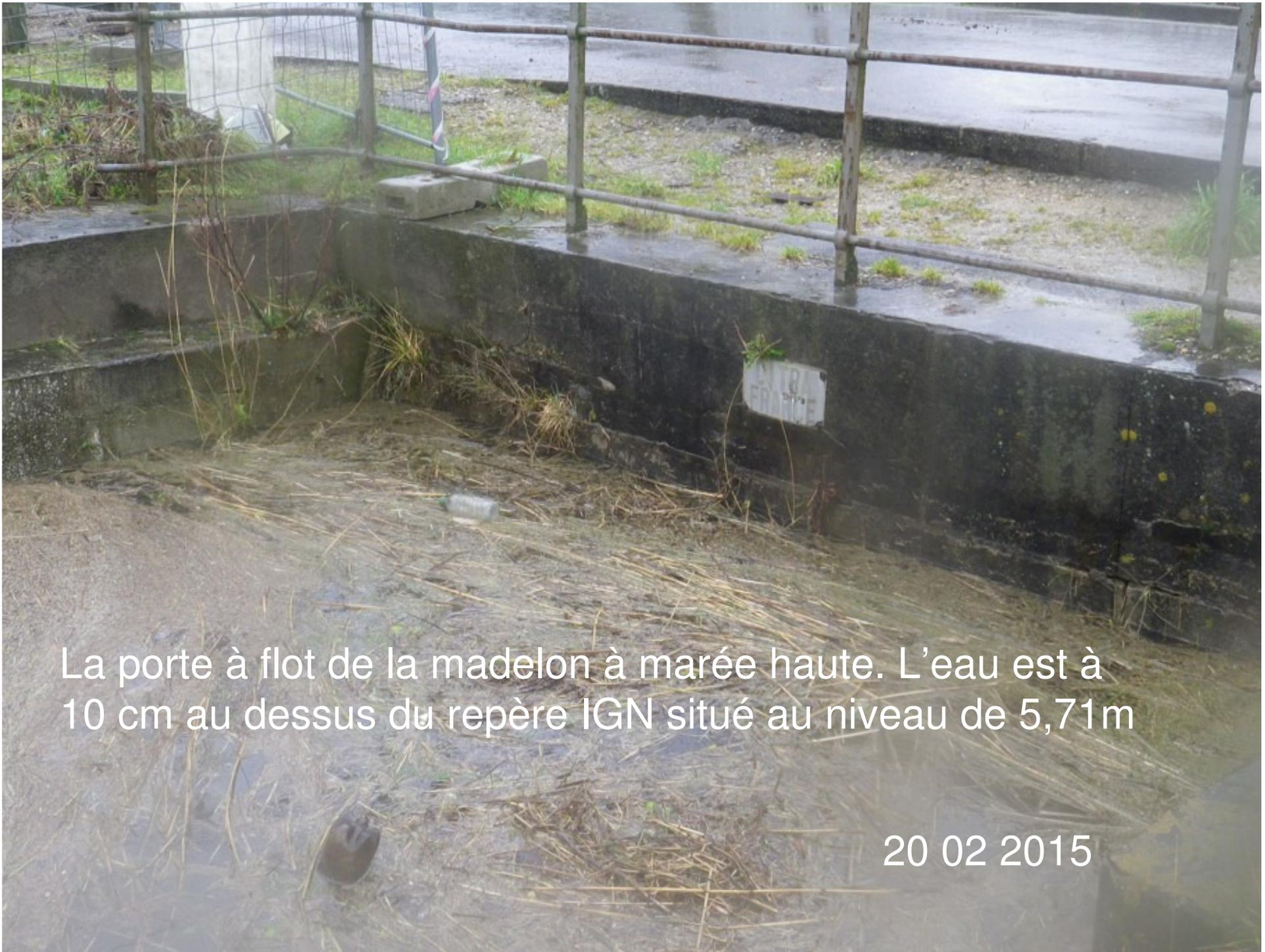
La porte à flot de la madelon à marée haute. L'eau est à 10 cm au dessus du repère IGN situé au niveau de 5,71 m
