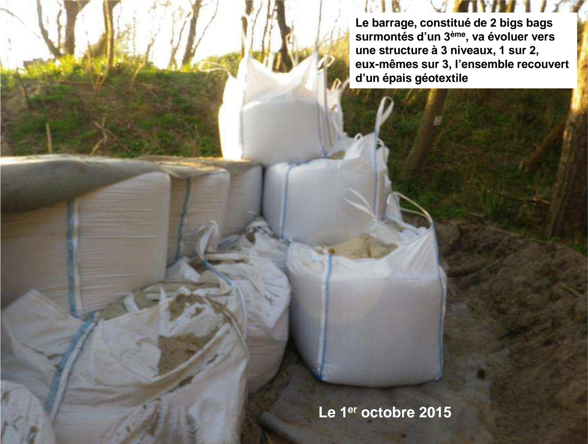
**Le barrage, constitué de 2 bigs bags surmontés d'un 3<sup>ème</sup>, va évoluer vers une structure à 3 niveaux, 1 sur 2, eux-mêmes sur 3, l'ensemble recouvert d'un épais géotextile**
