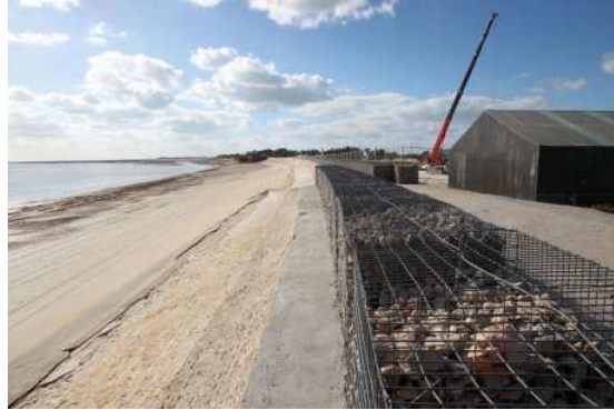
Les travaux de reconstruction de la digue du Boutillon dans l'île de Ré se poursuivent. (Photo P. Couillaud)
