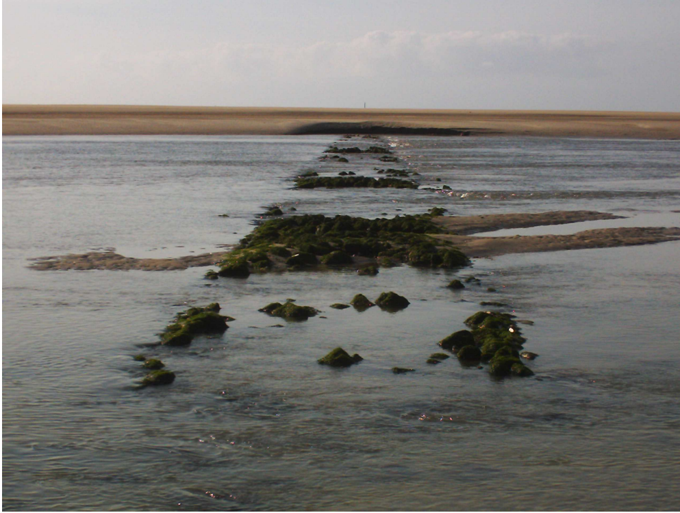
La digue Barrois était une digue de guidage du fleuve de moindre facture que l'enrochement actuel.
