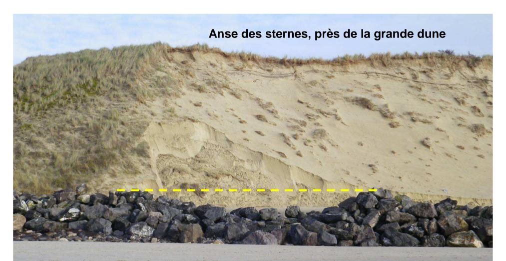
Nous avons ici un exemple flagrant du degré d'efficacité d'un l'enrochement. Il ne s'agit pas là d'un effondrement, l'enrochement avait été ouvert à cet endroit en mars avril 2011 pour permettre le passage des bennes transportant le sable en provenance de la plage de Berck.
