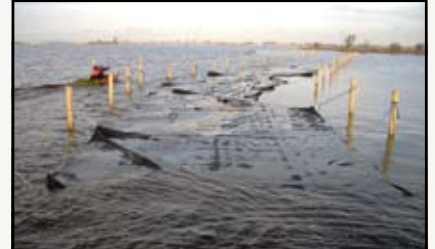
Système TenCate Geotube® prêt à être rempli de sable.
