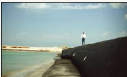
Les systèmes TenCate Geotube® sont empilés afin de constituer la structure de protection.
