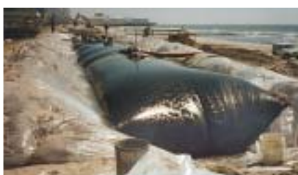
GEOTUBE UTILISÉ COMME REVÊTEMENT SUBMERGÉ POUR LA PROTECTION D'UN FRONT DE PLAGE
