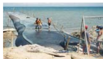
UTILISATION DE GEOTUBE POUR LA CONSTRUCTION D'ÉPIS
