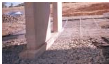
PROTECTION DE LIT AUTOUR DE PILES DE PONT UTILISANT LES FILTRES GÉOSYNTHÉTIQUES GEOLON
