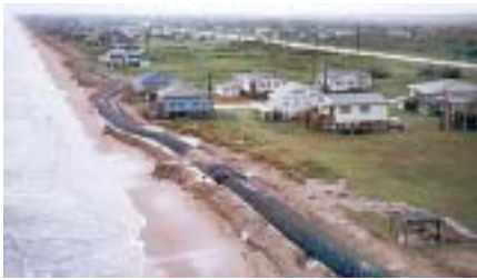
UTILISATION GEOTUBE POUR CONSTRUIRE DES DIGUES DE PROTECTION IMMERGÉES
