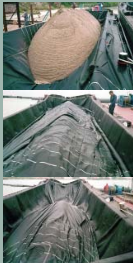
REMPLISSAGE ET INSTALLATION DE GEOCONTAINER POUR BUTÉE EN PIEDS DE BERGE
