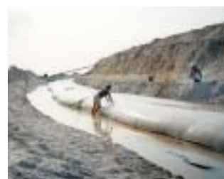
DIFFÉRENTS STADES DANS LE REMPLISSAGE GEOTUBE
