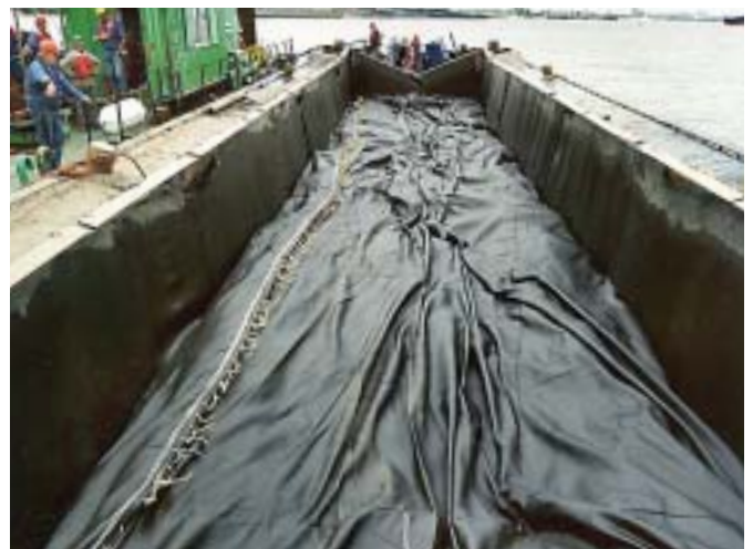
UTILISATION GEOCONTAINER POUR CONSTRUIRE DES DIGUES DE CONFINEMENTS SOUS-MARINES
