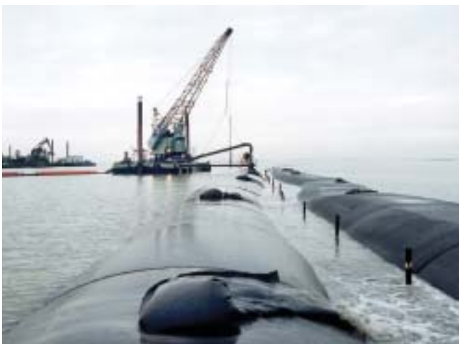
UTILISATION GEOTUBE POUR CONSTRUIRE DES DIGUES DE CONFINEMENT
