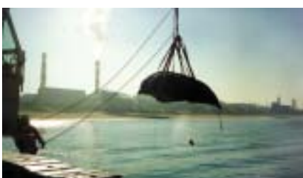
CONSTRUCTION DE RÉCIF ARTIFICIEL UTILISANT GEOBAG ET GEOCONTAINER
