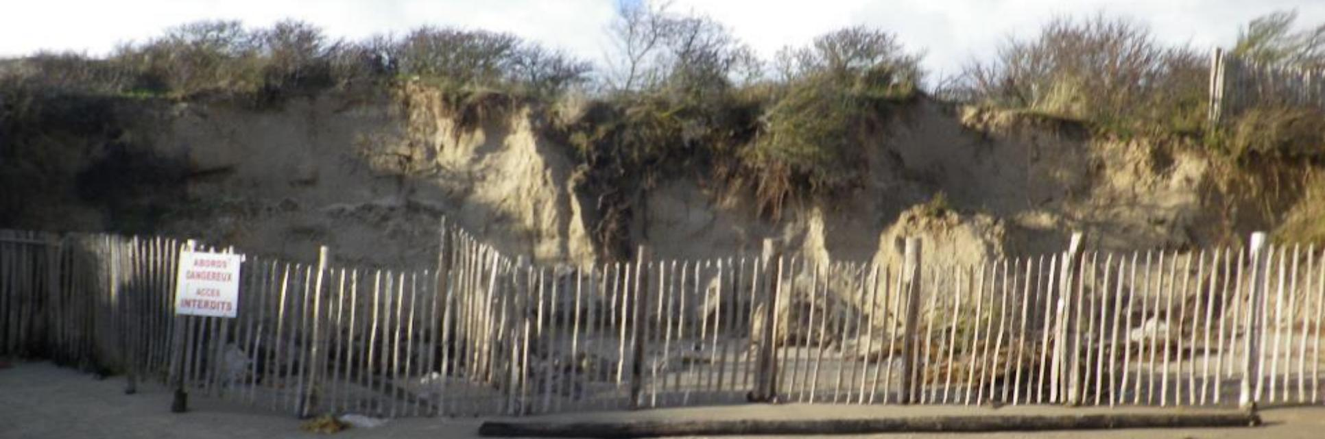
Un fort recul s'est produit sous les assauts de la houle, depuis l'accès à la mer du chemin dunaire jusqu'au niveau resté le plus haut de la digue submersible. Ce n'est vraiment pas nouveau. Depuis un bon moment, la digue submersible ne remplit plus que partiellement son rôle de brise lames et les enrochements protecteurs du pied de dune sont pour la plupart éparpillés ou enfouis et ne servent plus à grand-chose.
