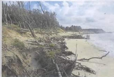
Le rechargement en sable et la pose de pieux en bois doit réduire l'érosion du cordon dunaire.
