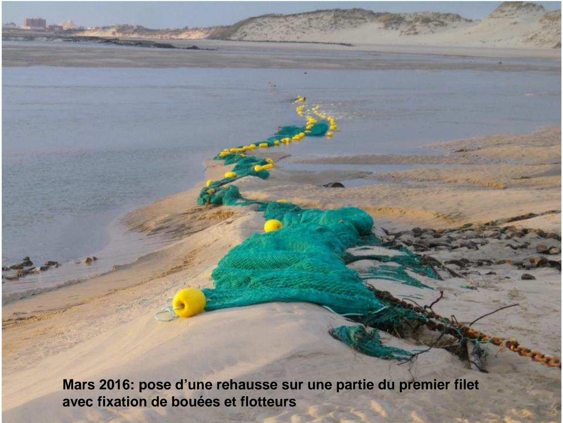
**Mars 2016: pose d'une rehausse sur une partie du premier filet avec fixation de bouées et flotteurs**
